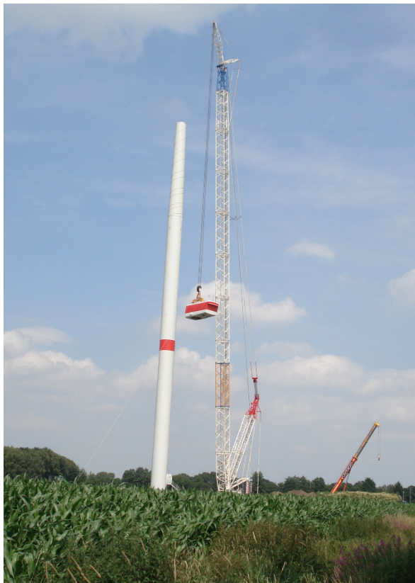
Montage des Maschinenhauses im Bürgerwindpark Hörstel Uthuisen.
